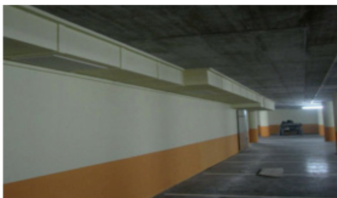
Slika 69: Klasični primer izvedbe MODT v garažah (požarni kanali za ODT)
