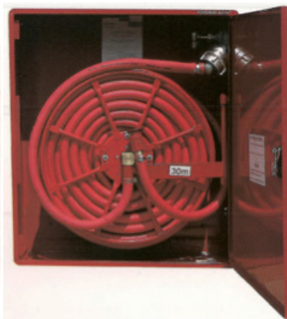
Slika 140: Notranji hidrant tipa G (s poltogo cevjo)
