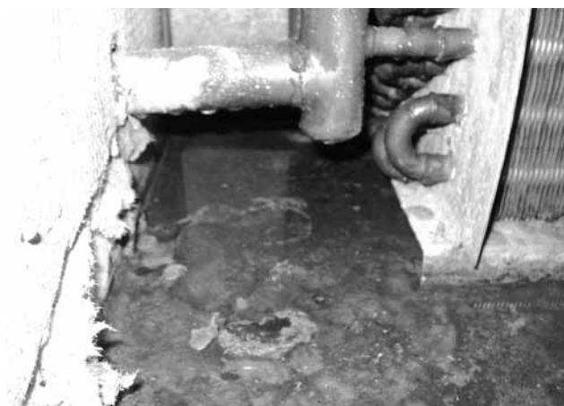
Slika 5 (Ne samo) kondenzat v zanemarjenem zbirnem koritu vir: medmrežje
