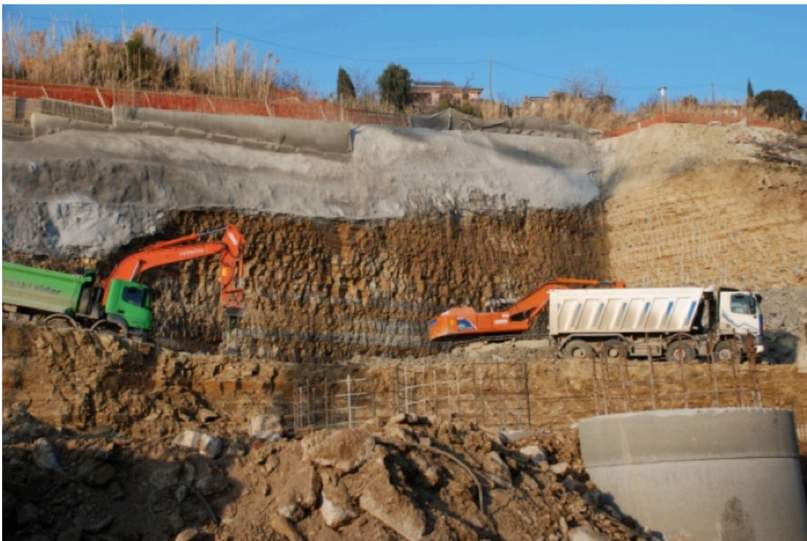
Slika 9: Prikaz zadnje izkopne faze in temeljenja garažne hiše Fornace
